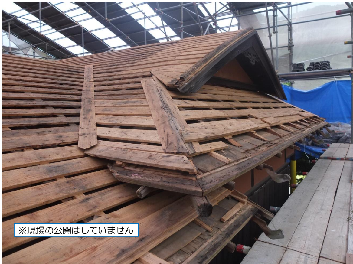
南の軒先から見た柿葺の撤去状況。 野地などの木下地状況が確認できます。
