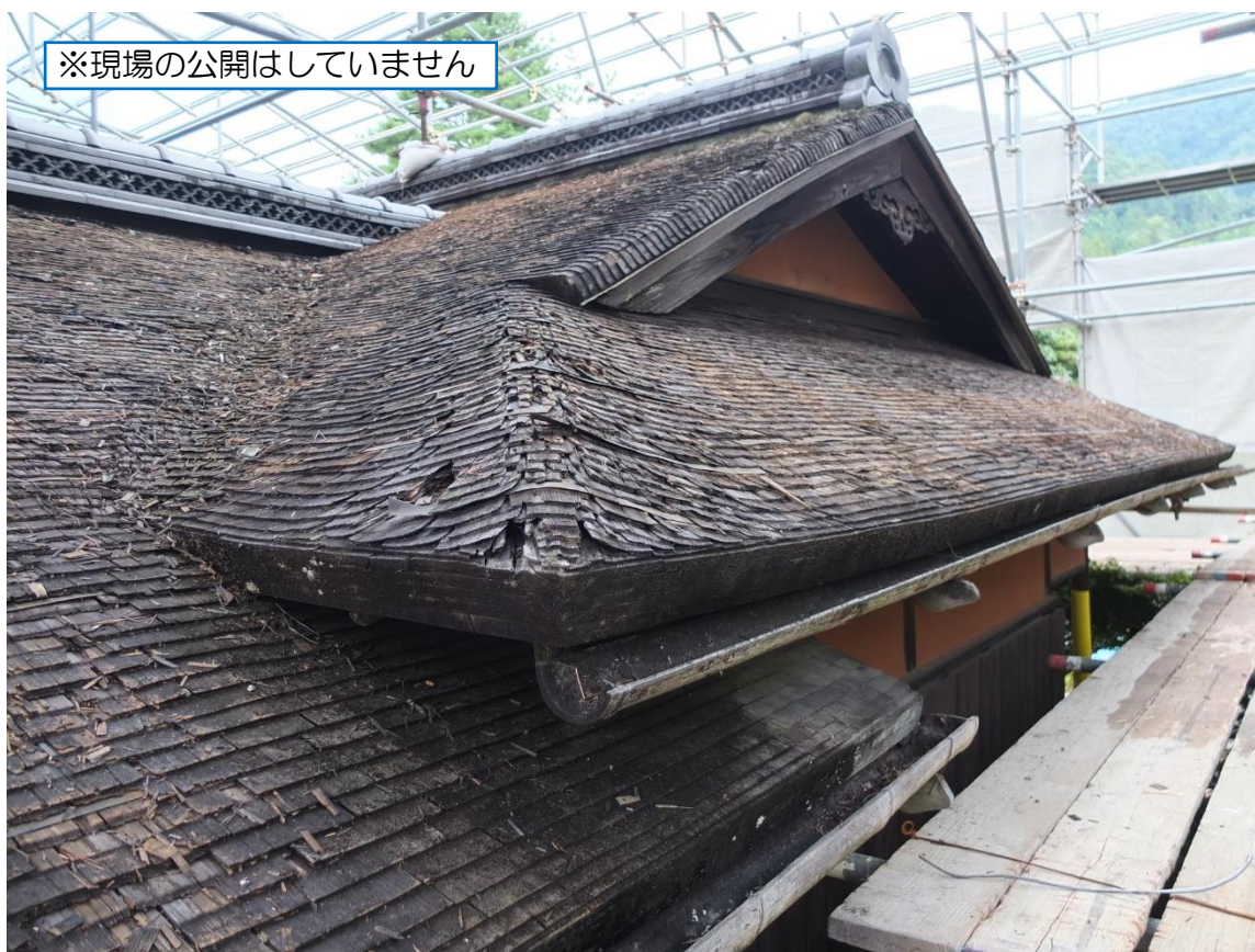
南西の軒先から見た葺替前の柿葺の状況。 前回の葺替から20年以上経過し、経年による腐朽がみられます。
