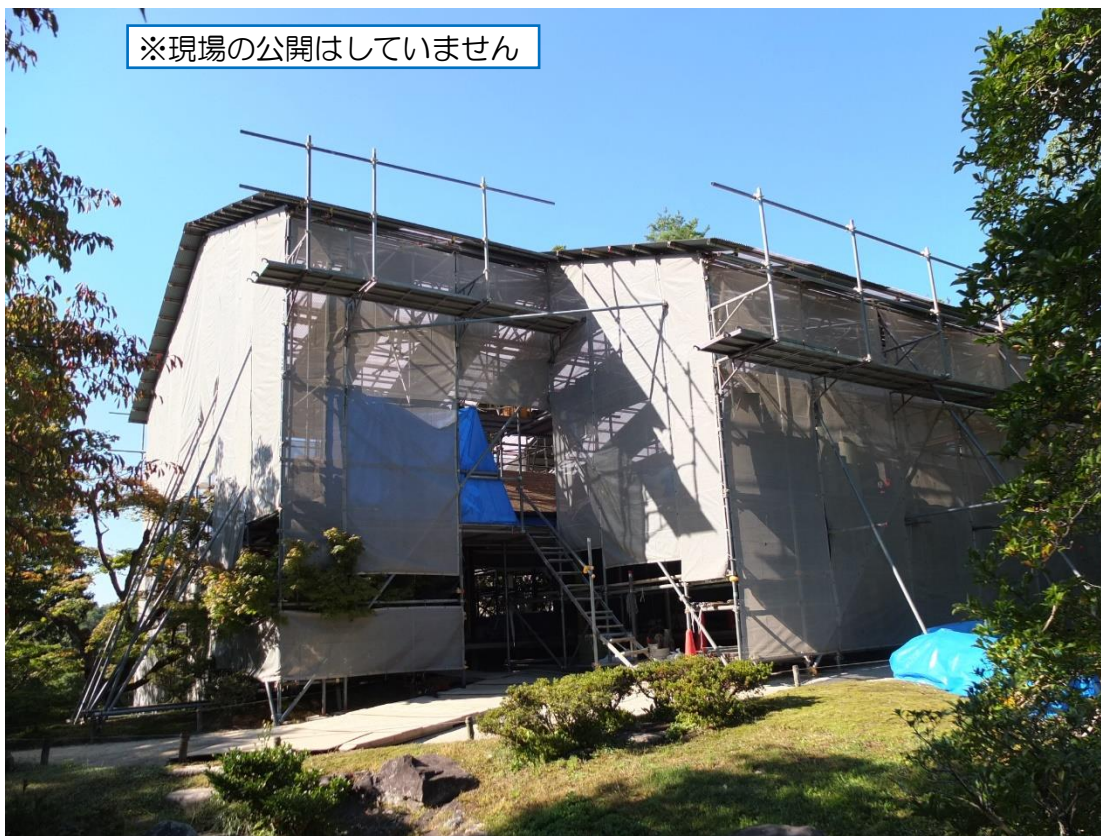
南東側から見た素屋根に覆われた寿月観の状況。 障壁画などは、あらかじめ修学院内の建物に移動した上養生しています。
