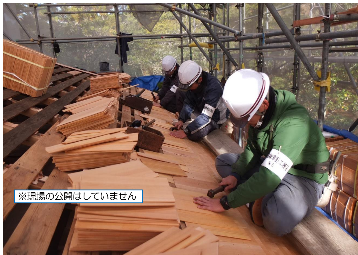
柿板（椀材）を並べて竹釘でとめていきます。 竹釘を口に含み、1本ずつ出しながら打ち付けていきます。
