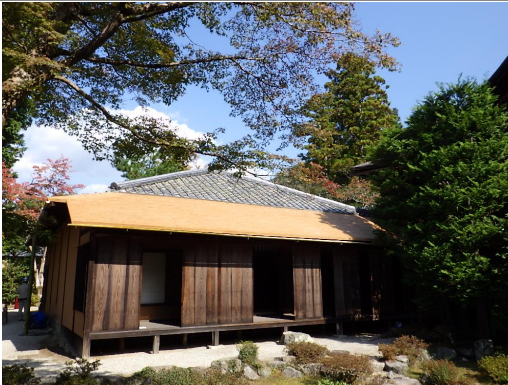
柿葺屋根の葺替が完了しました。
