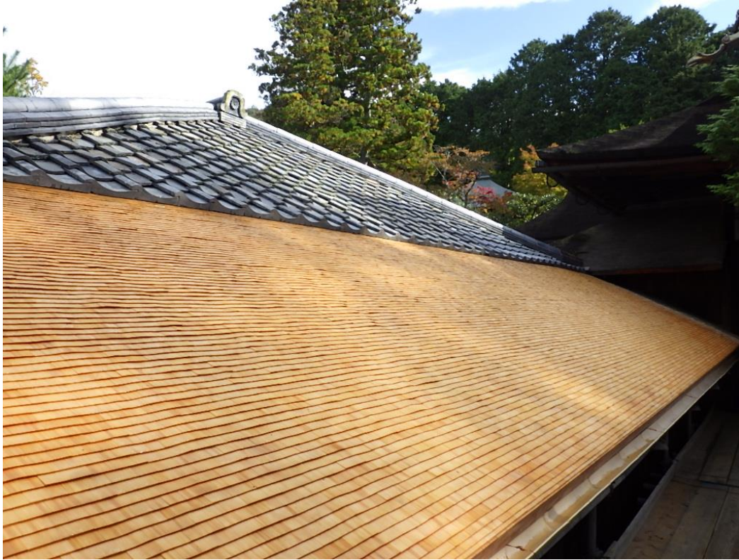
南西の軒先から見た葺替後の 柿葺 屋根です。
