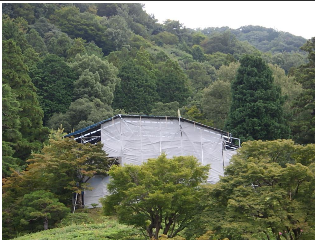
西側から見た素屋根に覆われた隣雲亭の状況。
