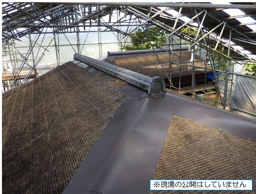
南東から見た柿葺屋根の状況。 屋根の劣化により雨漏りが生じており、応急処置としてカラー鉄板で養生していました。 今後、古い柿板を撤去し、新しい柿板で屋根を葺き上げていきます。
