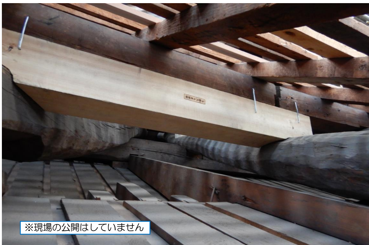
西側の屋根下地組補強の状況。 古くなった木材の継手箇所に隙間や腐朽が生じたため、屋根が重さで変形しないよう新しい木材を固定するような補強を数箇所行っています。
