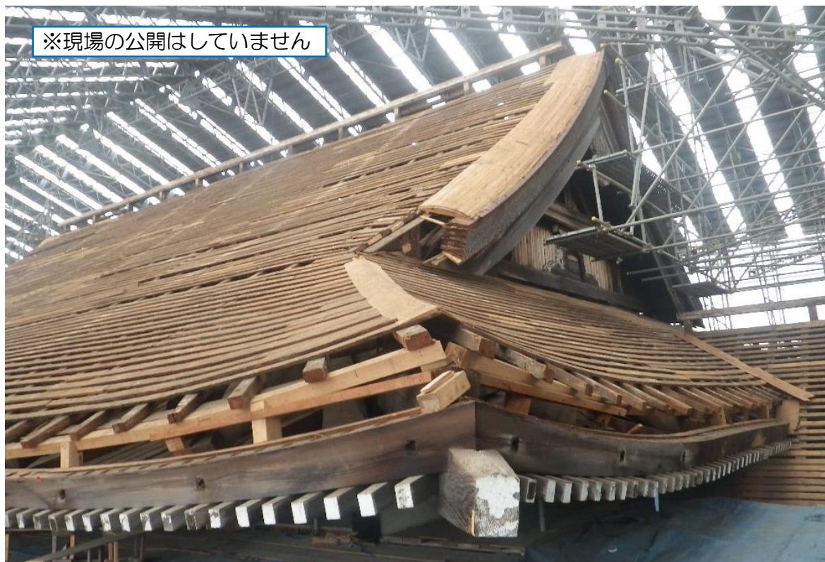
北東の軒先から見た桧皮葺の撤去状況。 野地などの木下地状況が確認できます。
