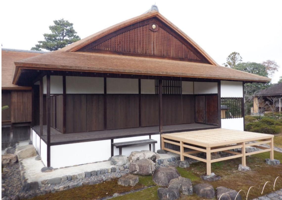
工事完了後の古書院の様子。 つきみだい 月見台を取り替えました。
