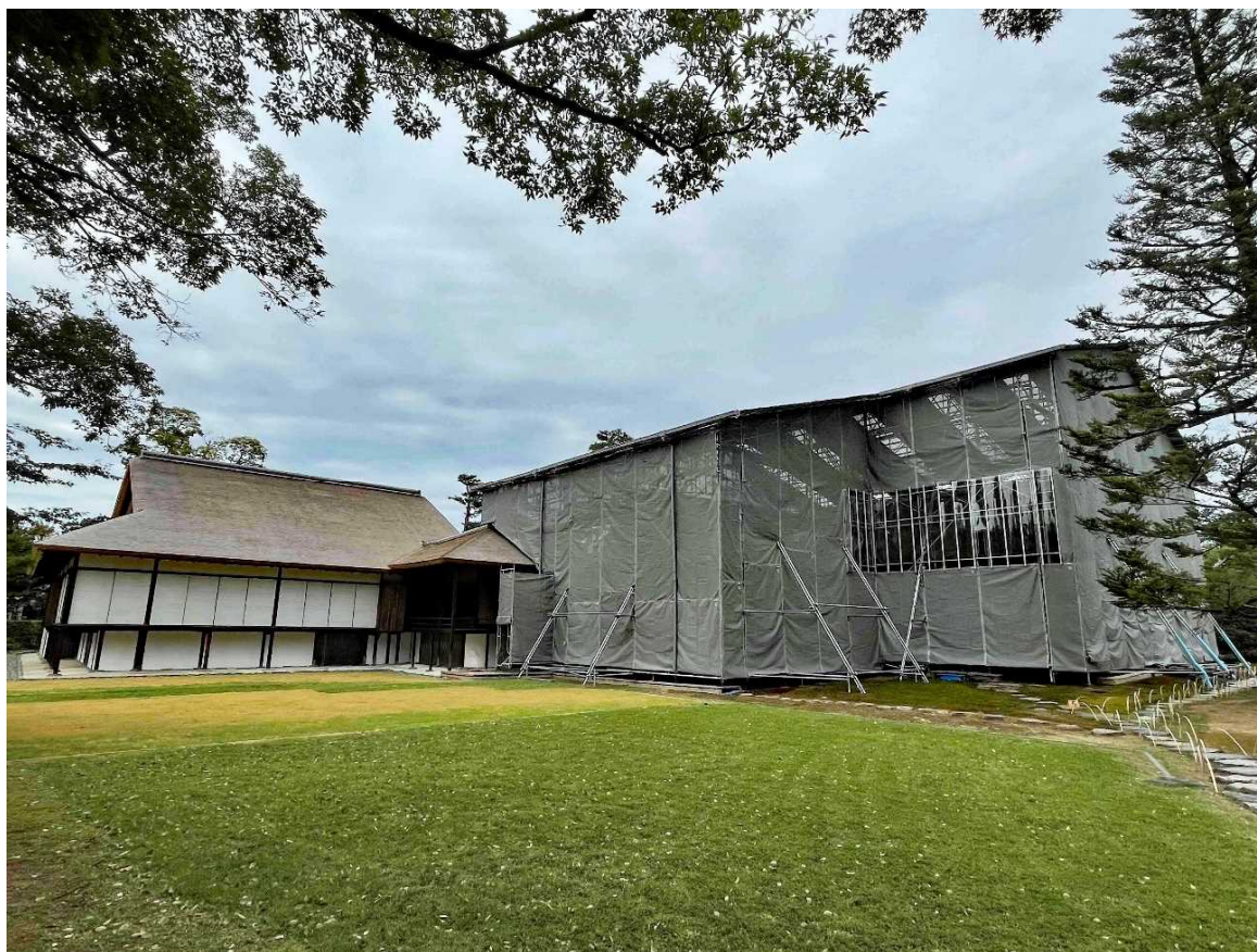
南側から見た素屋根撤去後の新御殿及び素屋根に覆われた古書院、中書院の状況。
