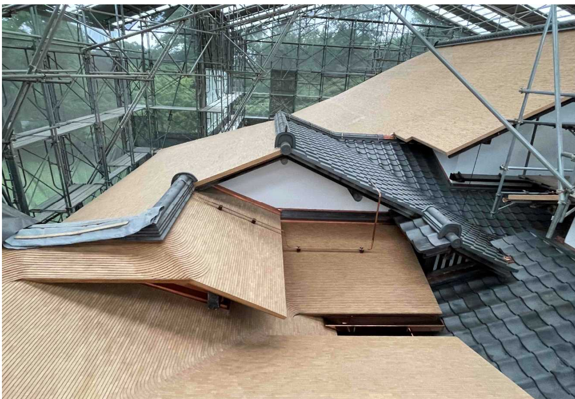
中書院北側から見た葺替後の柿葺及び瓦葺状況。
