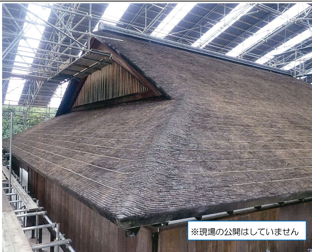
新御殿の軒先から見た葺替前の柿葺状況。 前回の葺替から20年以上経過し、屋根面の劣化がみられます。
