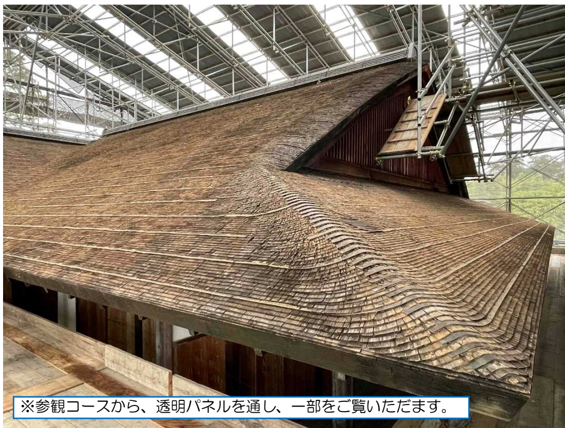
古書院の軒先から見た葺替前の柿葺状況。 前回の葺替から20年以上経過し、屋根面の劣化がみられます。
