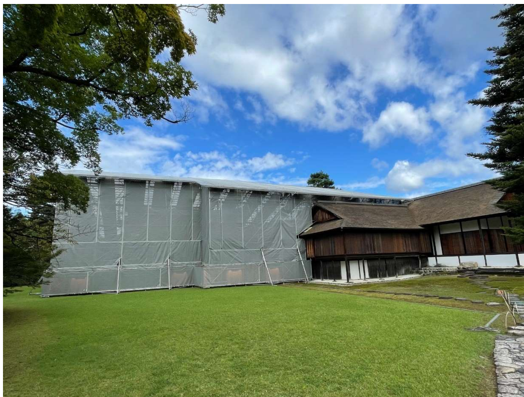
南側から見た素屋根に覆われた書院の状況。
