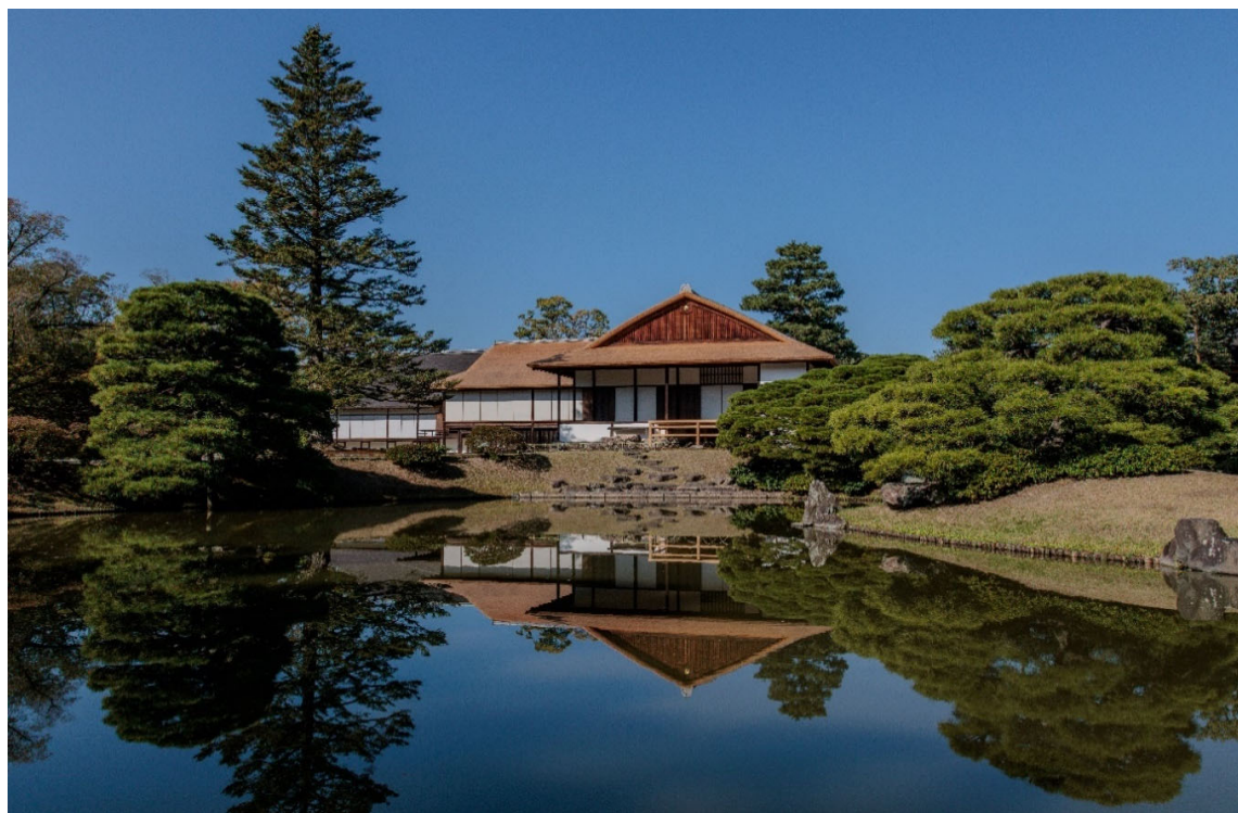
工事完了後の御殿を東側から池越しに見た状況。
