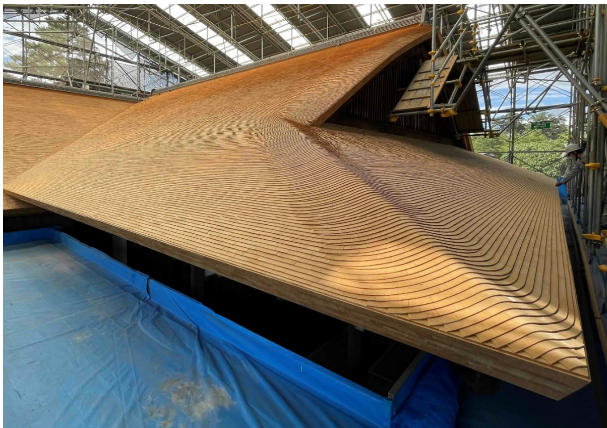
古書院の軒先から見た葺替後の柿葺状況。
